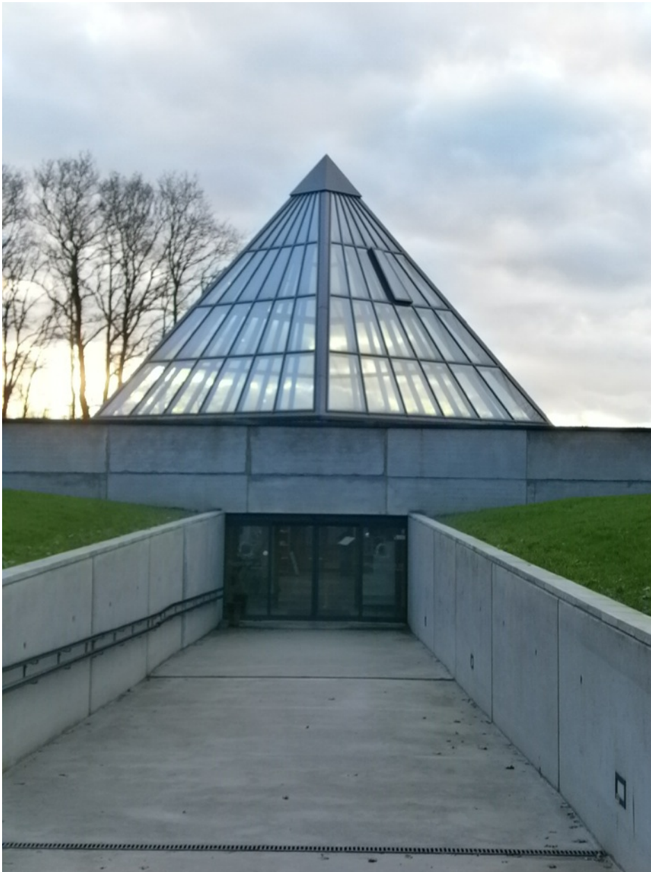
Le Centre vu de l'extérieur
